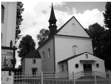
Kościół parafialny pw. Narodzenia Najświętszej Maryi Panny w Krzywcy, 2013 r.
